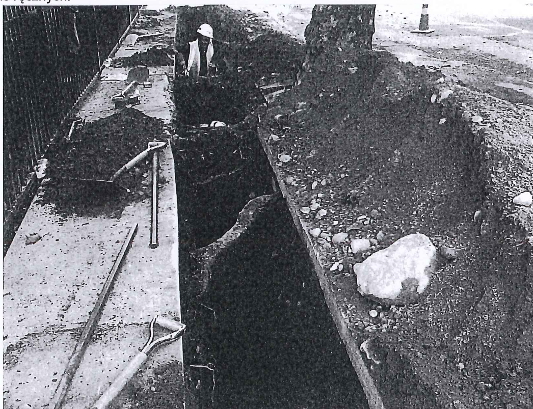
Powyżej: zdjęcie prawidłowo wykonanych prac wykopowych bez naruszenia szkieletowego systemu korzeniowego platana klonolistnego
